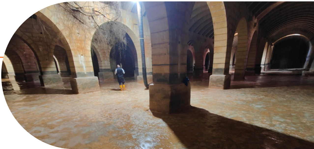
FIG Ta' Qali .06 Reservoir
